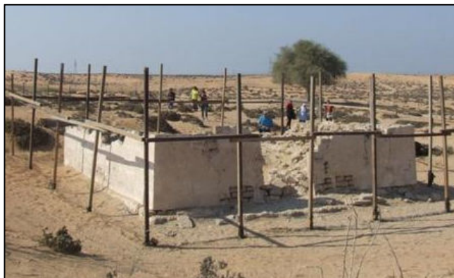
UAE/1/001 : Des recherches à partir des résultats de fouilles archéologiques constatations archéologiques au temple d'Al-Dor, dans l'Umm al-Quwain, confirment que celui-ci a été construit avec du plâtre à base de calcite, et non du gypse, et ont permis de déterminer l'origine du mortier utilisé.
