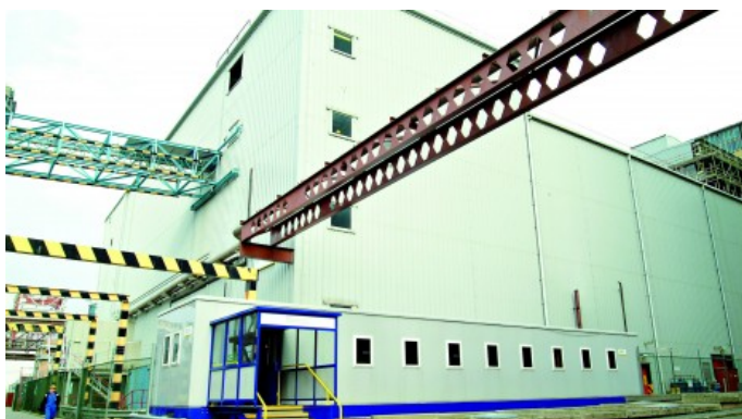
Fig. A-8. La planta de reprocesamiento Magnox, en Sellafield, cumplió 50 años de funcionamiento. (Fotografía: Sellafield Ltd).
