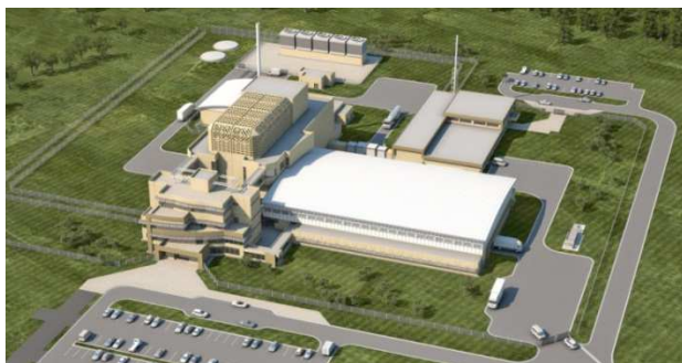
FIG. C-3. L'Autorité de réglementation nucléaire de l'Argentine a accordé une licence de construction pour le réacteur de recherche RA-10, qui servira à augmenter la production de radio-isotopes du pays pour les essais de matériaux/combustibles, le dopage du silicium, ainsi que pour la recherche-développement. (Image : Commission nationale de l'énergie atomique)
