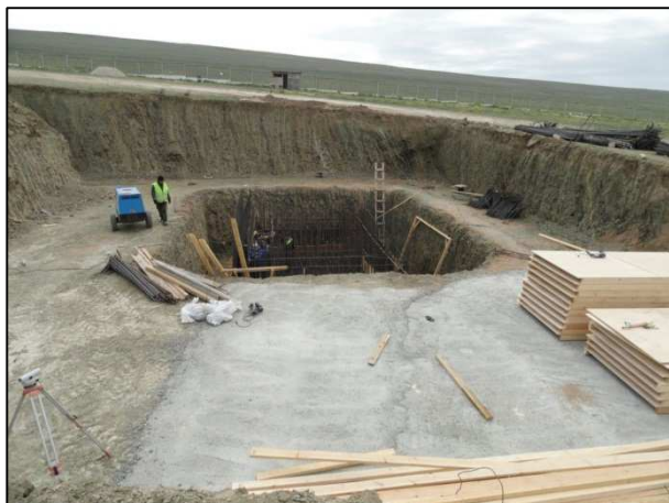
AZB/8/002 : Premiers travaux de construction de l'installation de radiotraitement en Azerbaïdjan.
