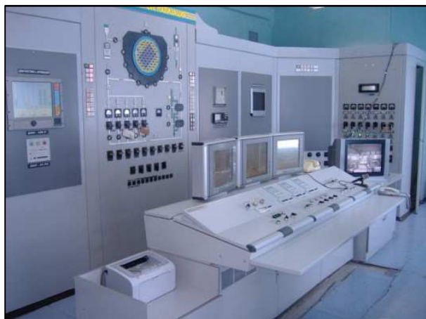
UZB/9/005 : Nouvelle console de contrôle-commande numérique du réacteur de recherche WWR-SM (Ouzbékistan).
