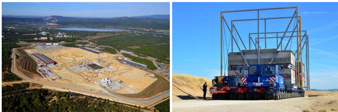
Fig. B-4. Le site d'ITER en septembre 2013 (à gauche). La remorque de 800 tonnes, tractée par un véhicule téléguidé, reproduisant le poids et les dimensions des charges les plus volumineuses d'ITER (10 m de haut, 33 m de long, 9 m de large), a avancé à une vitesse moyenne de 5 km/h pendant quatre nuits consécutives pour tester l'itinéraire spécial de 104 km (à droite). (Photos : ITER)
