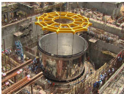
Fig. B-1. Les travaux de construction du prototype de surgénérateur à neutrons rapides de Kalpakkam (Inde), sont bien avancés. (Photo : Centre de recherche atomique Indira Gandhi)
