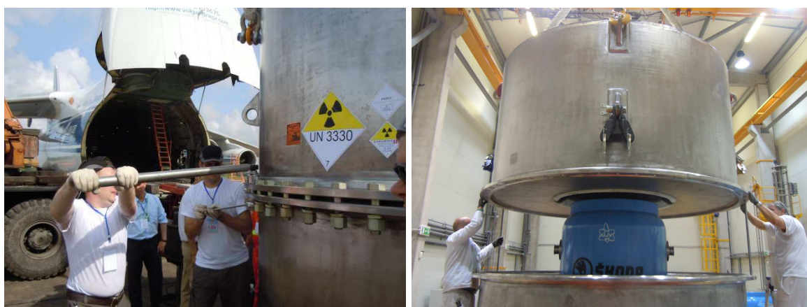
Fig. C-5. À gauche : Boulonnage de colis de transport spéciaux renfermant du combustible usé à l'UHE pour les expédier de l'Institut vietnamien de recherche nucléaire de Dalat en Fédération de Russie. À droite : Pose d'un suremballage de protection sur un château de transport contenant du combustible usé à l'UHE en provenance du réacteur de recherche de Budapest, en Hongrie. Ce suremballage a été conçu pour permettre le transport aérien.
