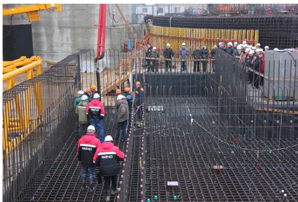
Fig. A-4 La construction de la première centrale nucléaire du Bélarus a commencé sur le site d'Ostrovets le 6 novembre 2013. (Photo : Direction pour la construction de centrales nucléaires, Bélarus)
