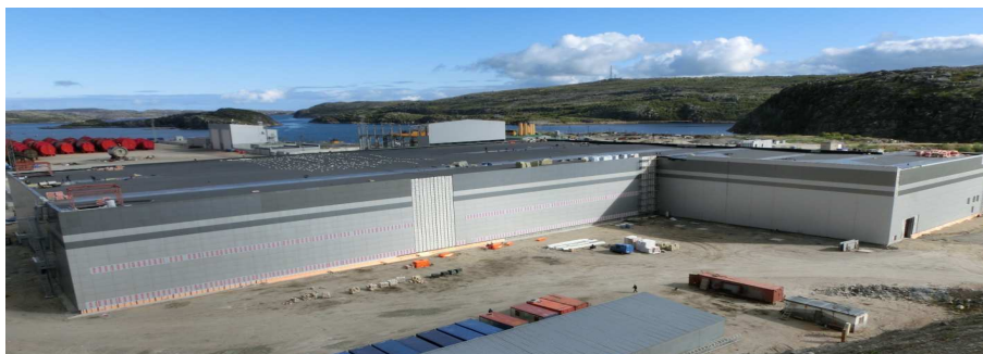
Fig. A-14. Construction du Centre régional de conditionnement et d'entreposage à long terme des déchets radioactifs dans le nord-ouest de la Russie. (Photo : Energiewerke Nord GmbH)
