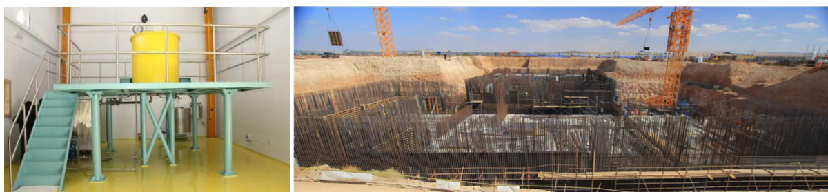
Fig. C-4. À gauche : L'assemblage sous-critique jordanien de puissance nulle a reçu une licence d'exploitation en juin 2013 (Photo: Université jordanienne des sciences et des technologies). À droite : la construction du réacteur jordanien de recherche et de formation de 5 MW était achevée à 49 % en octobre 2013. (Photo : Commission jordanienne de l'énergie atomique)
