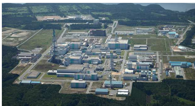
Fig. A-13 Usine de retraitement de Rokkasho (Japon). (Photo : JNFL)
