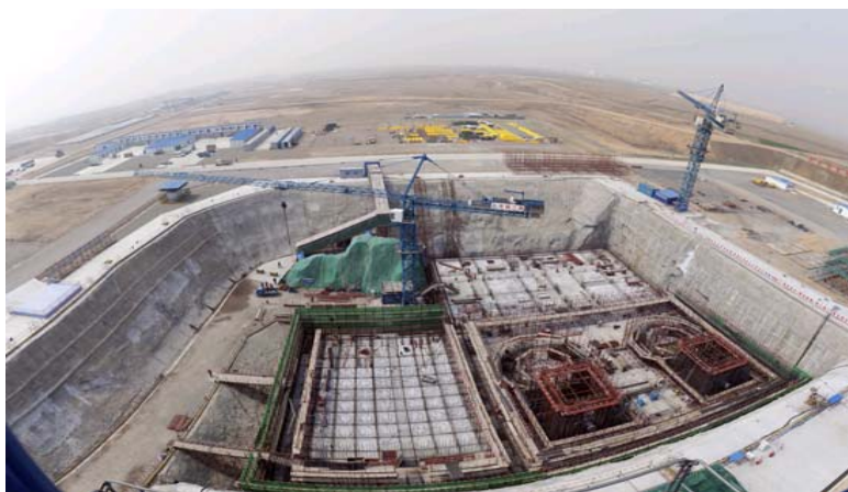
图 B-2. 中国威海市石岛湾球床模块式高温堆建设工地（照片由核能与新能源技术研究院提供）。
