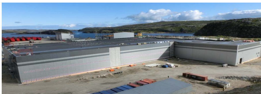
图 A-14. 在俄罗斯西北建造放射性废物整备和长期贮存地区中心（照片由 Energiewerke Nord GmbH 公司提供）。
