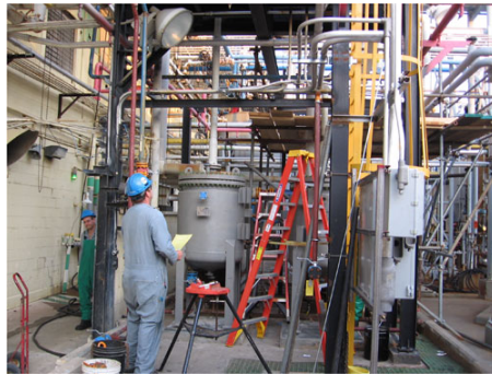
الشكل ألف-١٠ - جهاز جديد لتبخير فلوريد الهيدروجين في مرفق هانيويل ميتروبوليس وركس في ولاية إيلينوي بالولايات المتحدة الأمريكية. (الصورة من: شركة كوفريدين)
