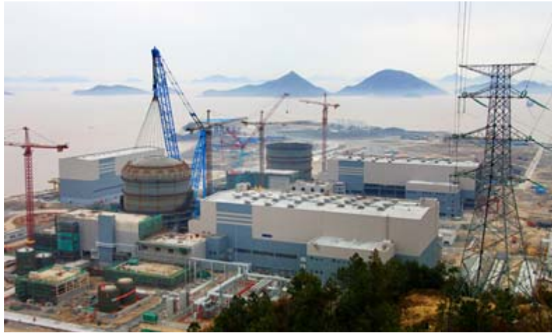
图 3. 作为正在扩大核电计划的国家，中国多座在建核电厂之一的三门核电站一台机组的安全壳顶封正在安装中（照片由中核集团公司提供）。
