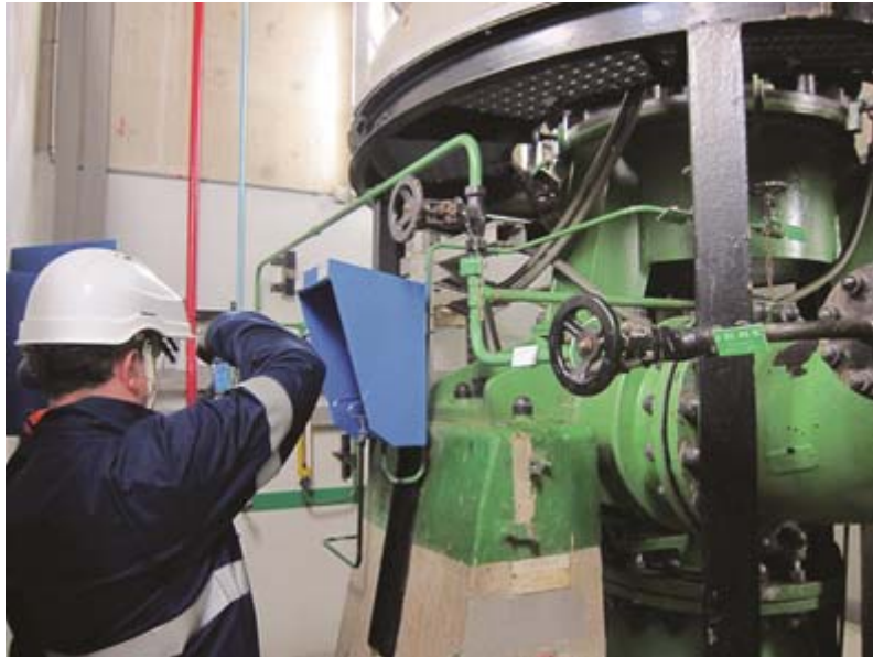
图 1. 参加运行安全评审组后续工作组访问的一名原子能机构评审人员正在评价法国格拉弗林核电站一个主要厂用水泵的功能。
