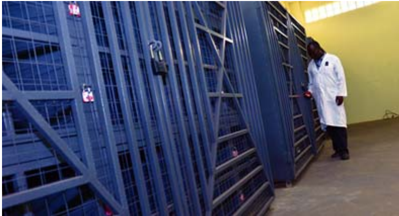
图 2. 加纳一座设施的安全贮存库，其中纳入了各种类型的实体屏障以防盗窃和擅自接触放射性物质。
