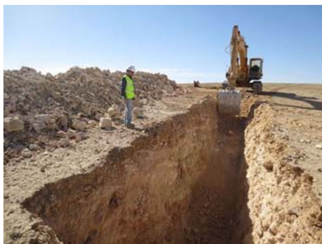
图1. 在约旦中部地区的一个铀矿床开挖一条用于评价的沟槽。
