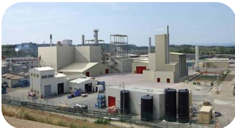
Fig. A-8. COMURHEX II Instalación de conversión que se está construyendo en Francia. La puesta en servicio gradual está prevista para 2013-2014
