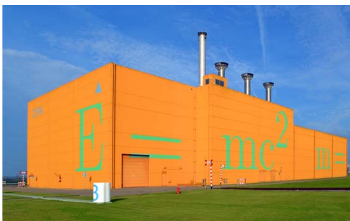
Fig. A-11. Instalación de almacenamiento de desechos de actividad intermedia HABOG, Países Bajos.
