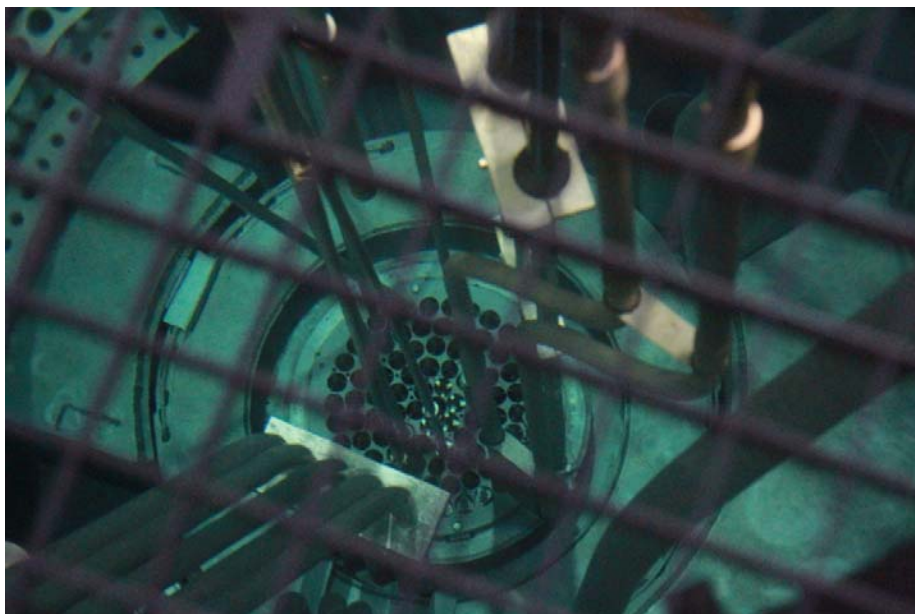
Fig. C-6. El núcleo del reactor de investigación tipo Triga Mark-II que utiliza combustible de UPE, de la Universidad Técnica de Viena. El reactor se convirtió en 2012 para que utilizara UPE en lugar de UME.
