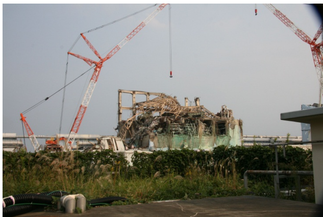
Fig. A-15. Central nuclear de Fukushima Daiichi de la TEPCO, octubre de 2011
