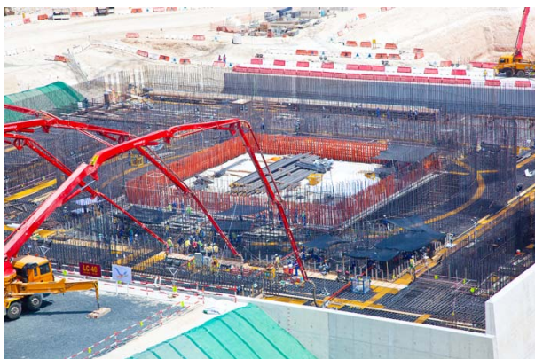
Fig. A-1. Construcción en Barakah-1 en los Emiratos Árabes Unidos (Fotografía: ENEC).
