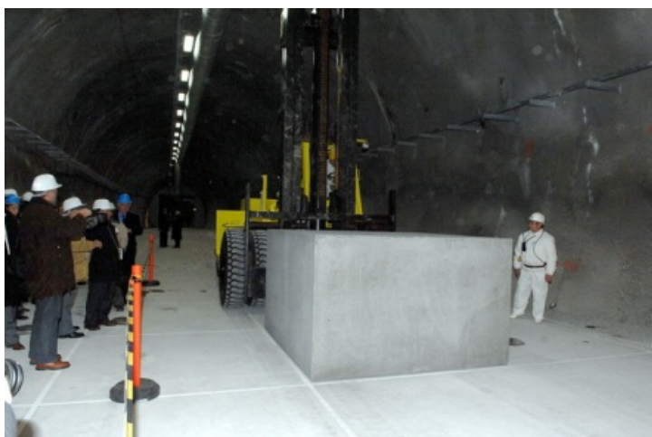
Fig. A-13. Colocación del primer bulto de desechos en la instalación de Bátaapáti (Hungria), para su disposición final.
