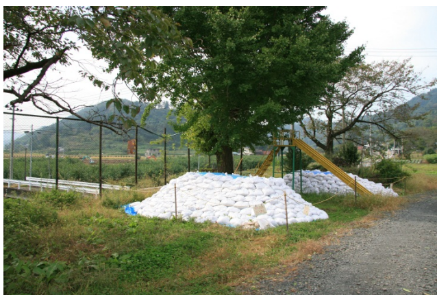
Fig. A-16. Almacenamiento provisional de tierra retirada en un proyecto modelo de restauración en la escuela primaria de Tominari, ciudad de Date, octubre de 2011.
