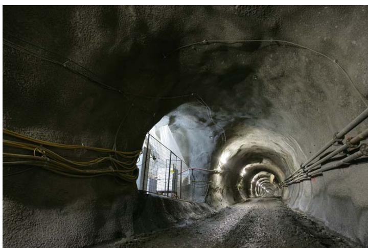
Fig. A-12. Rampa de acceso a la instalación nacional de disposición final de desechos radiactivos en Bátaapáti (Hungria).
