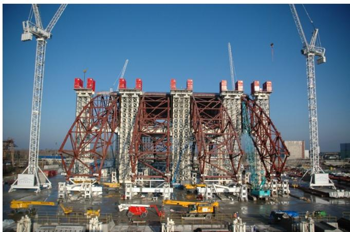
*РИС. А-18. Строительство нового безопасного укрытия для четвертого энергоблока Чернобыльской АЭС (фотографию предоставила Чернобыльская АЭС).*
