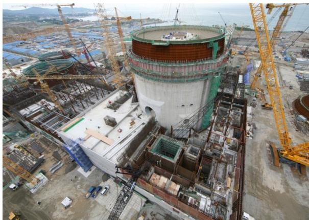
*РИС. А-2. Строительство энергоблока «Син-Кори-3» в Республике Корея.*
