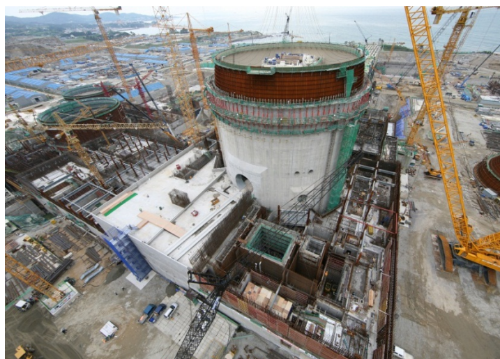
FIG. A-2. Construction à la centrale de Shin Kori 3 en République de Corée.
