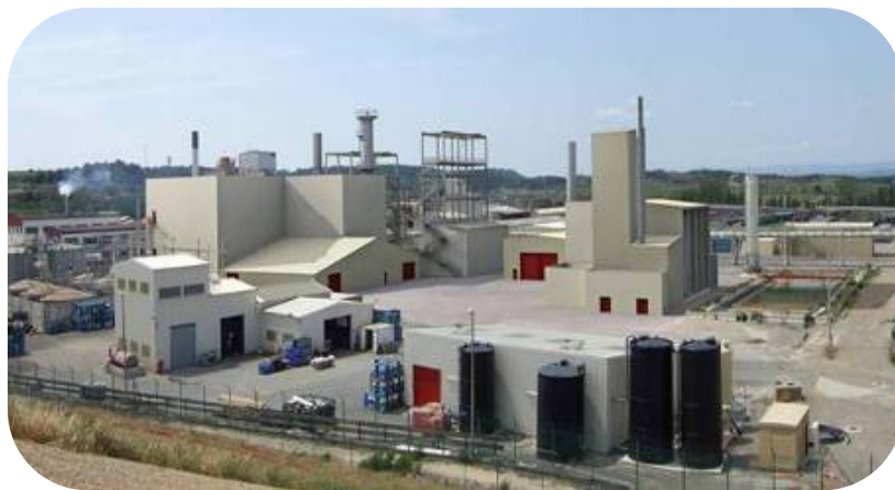
FIG. A-8. Usine de conversion COMURHEX II en construction en France. Sa mise en service progressive devrait intervenir en 2013-2014.
