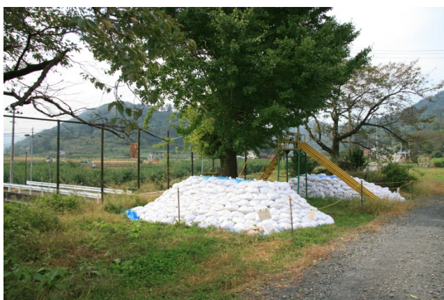
FIG. A-16. Entreposage provisoire de terre enlevée dans le cadre du projet type de remédiation à l'école élémentaire Tominari de Date, octobre 2011.
