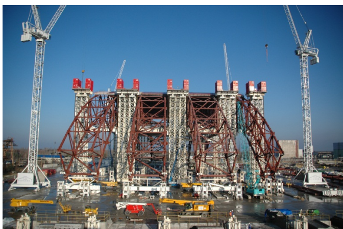
FIG. A-18. Montage de la nouvelle enveloppe de confinement sûre pour la quatrième tranche à la centrale de Tchernobyl (Photo : centrale nucléaire de Tchernobyl).
