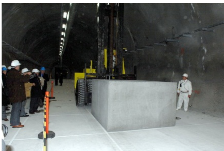
FIG. A-13. Mise en place du premier colis de déchets dans l'installation de stockage définitif de Bataapáti (Hongrie).
