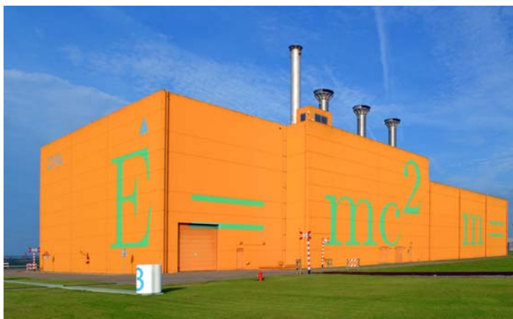
FIG. A-11. Installation d'entreposage intermédiaire de déchets HABOG (Pays-Bas).
