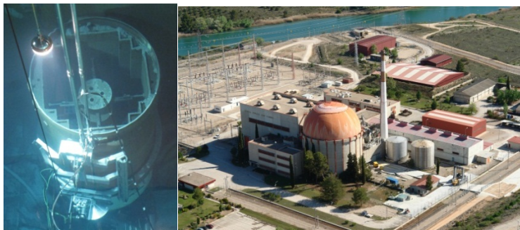
FIG. A-17. Démantèlement des internes du réacteur (à gauche) à la centrale nucléaire Jose Cabrera (à droite) (Photo : ENRESA).
