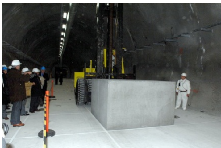
الشكل ألف-١٣ - وضع أول مجموعة للتخلص من النفايات داخل مرفق التخلص في باتاباتي، المجر.
