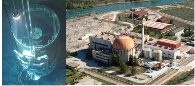
الشكل ألف-١٧ - تفكيك المكونات الداخلية للمفاعل (يساراً) في محطة خوسيه كابريرا للقوى النووية (يميناً) (الصورة: المؤسسة الوطنية للنفابيات المشعة).
