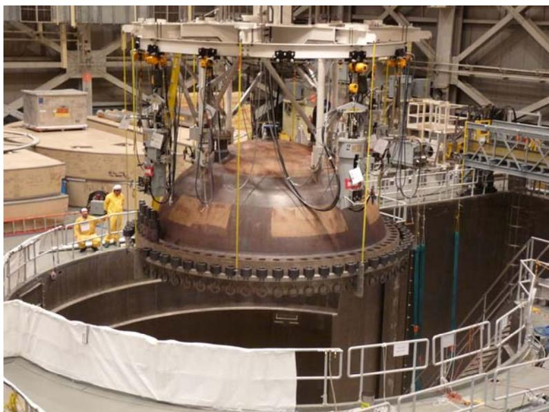
*РИС. 4. Подъем крышки корпуса реактора АЭС "Лагуна-Верде" в Мексике.
