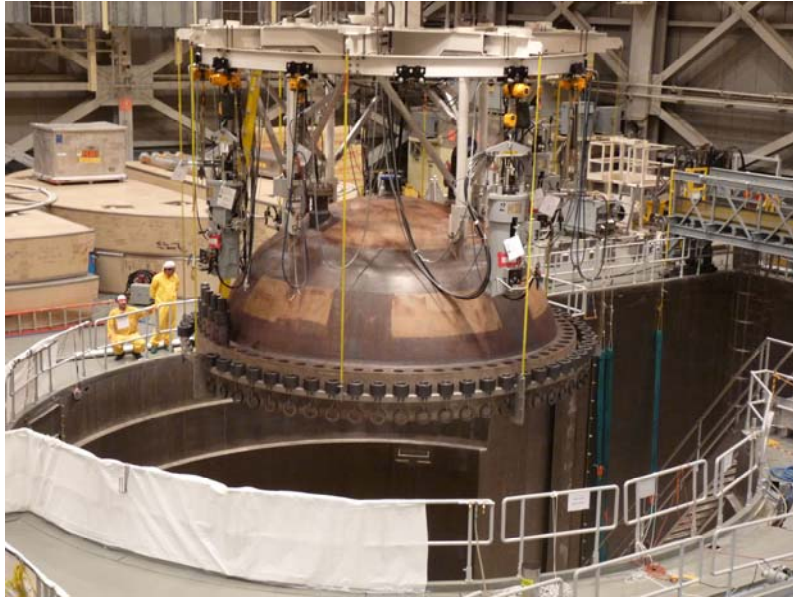
الشكل ٤ - رفع رأس وعاء مفاعل في محطة لاغونا فيردي للقوى النووية في المكسيك . وقد زارت بعثة من فرقة استعراض أمان التشغيل هذه المحطة .
