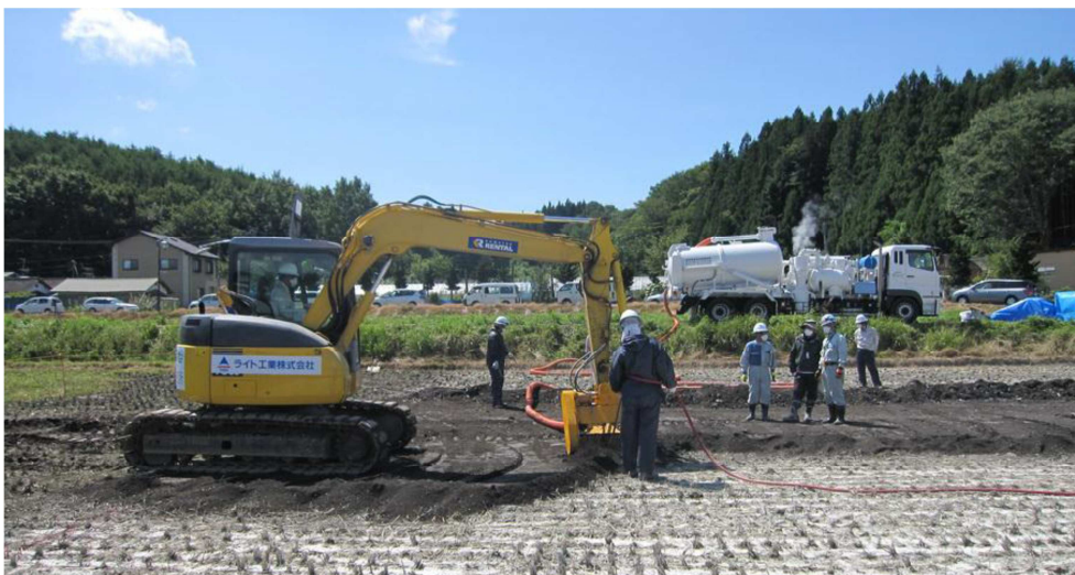
Fig. D.3. Ensayo de retirada de la capa superficial del suelo tras aplicar un endurecedor (por cortesía del Ministerio de Agricultura, Silvicultura y Pesca (MAFF), el Organismo de Energía Atómica del Japón (JAEA) y la Organización Nacional de Agricultura y Alimentación (NARO)(Japón)).
