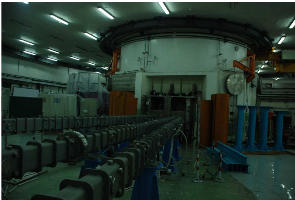
FIG. D-2. Reactor de investigación avanzado de China.
