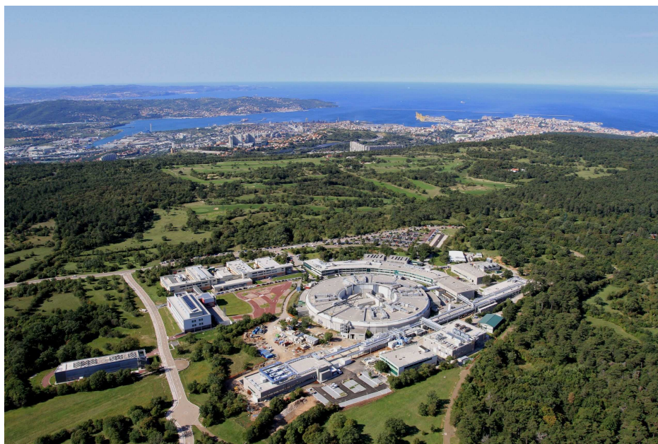
Fig. 3. Vista aérea de la instalación de Elettra, Trieste (Italia).
