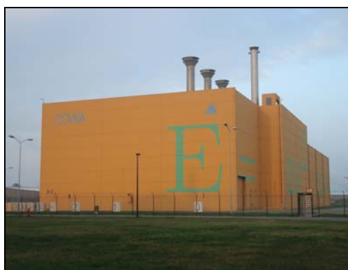
Fig. 1. Bâtiment destiné au stockage provisoire des déchets radioactifs de haute activité et du combustible usé sur le site du COVRA, aux Pays-Bas, qui est conçu pour assurer un stockage sans risque pendant au moins 100 ans.
