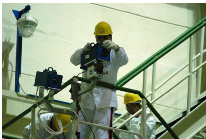
Fig. 2. Mise en place de matériel de surveillance dans une installation nucléaire.
