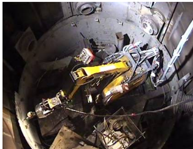
Fig. 3. Enlèvement télécommandé du revêtement au réacteur de recherche à Grenoble (France).
