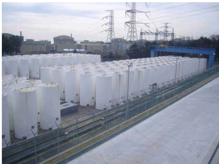
Fig. 2. Châteaux d'entreposage à sec sur le site de la centrale nucléaire de Wolsong en République de Corée.
