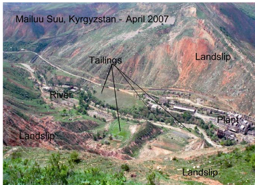
Fig. 5. Le site de Mailuu-Suu au Kirghizistan : les amas de résidus sont au centre de la photo, et les éboulements potentiels sont à gauche (sol rouge) et de l'autre côté de la rivière, sur le flanc de la colline.
