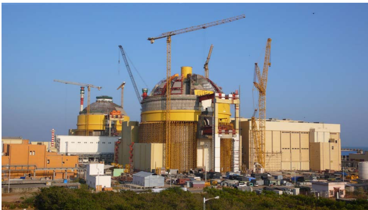
Fig. 1. Construction de réacteurs refroidis par eau [2 × 917 MW(e)] à Kundankulam (Inde).
