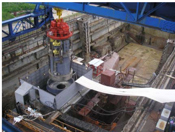
Fig. 6. Le déchargement du combustible d'un sous-marin nucléaire endommagé a nécessité l'enlèvement du cœur du réacteur refroidi par métal liquide.
