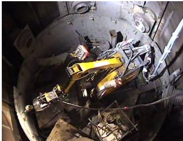
图 3. 在法国格勒诺布尔 SILOE 研究堆通过远程操作移除衬里。
