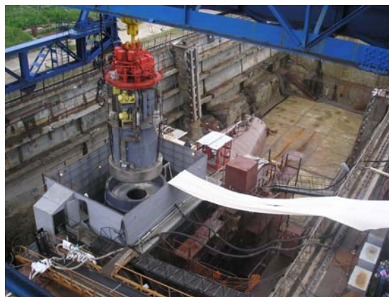
图 6. 拆卸已损坏核潜艇的燃料涉及拆除采用液态金属冷却的反应堆堆芯。
