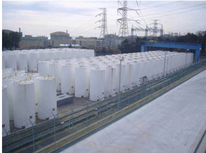
图 2. 大韩民国月城核电厂场址的干法贮存罐。
