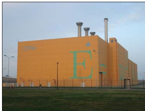
图 1. 荷兰中央放射性废物管理组织场址用于临时贮存高放废物和乏燃料的建筑物，其设计可提供至少 100 年的安全贮存。
