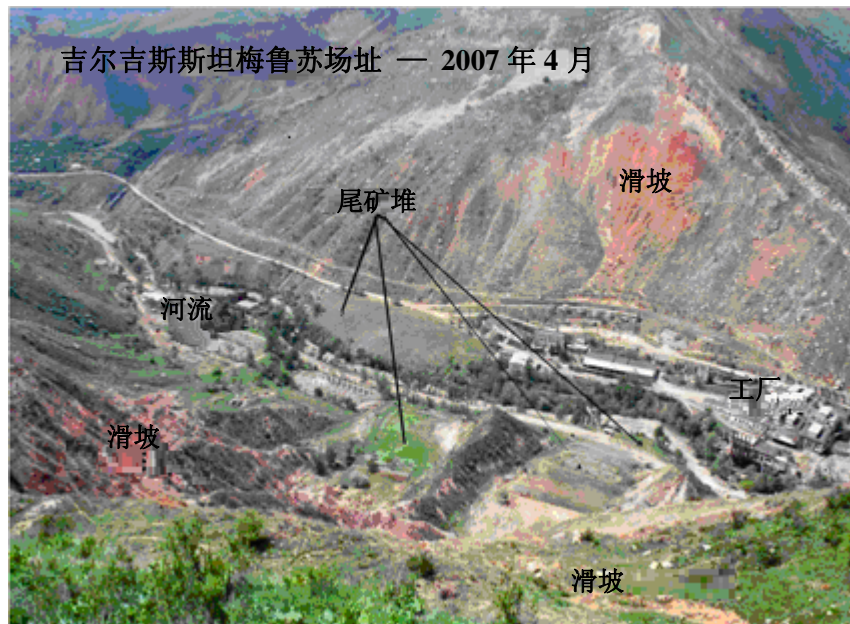
图 5. 吉尔吉斯斯坦梅鲁苏场址：图片中央为尾矿堆，河流左侧和对面的山坡为潜在的滑坡带（红色土壤）。
