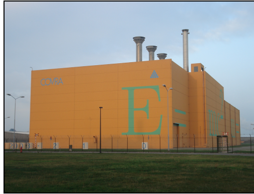
الشكل- ١. بناية خاصة بالخبز المؤقت للنفايات القوية الإشعاع والوقود المستهلك في موقع الهيئة المركزية للنفايات المشعة، بهولندا، وهي مصممة للخبز الآمن لمدة ١٠٠ سنة على الأقل.
