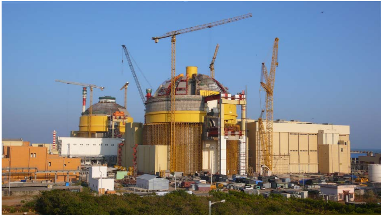
الشكل ١. بناء مفاعلات مبردة بالماء (٢ × ٩١٧ ميغاواط (كهربائي)) في كوندانكولام، بالهند.
