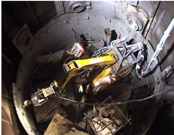
الشكل-٣ . عملية إزالة بطانة مُشغلة عن بُعد في مفاعل البحوث سيلو في غرينوبل بفرنسا.
