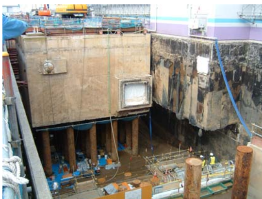
图 2. 铲除、清理和更换柏崎-刈羽核电厂非安全相关结构桩基下被石油污染的土壤。
