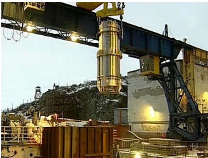
图 3. 从格列米哈前海军基地拆除潜艇乏核燃料，以供在俄罗斯联邦马雅克工厂进行后处理。
