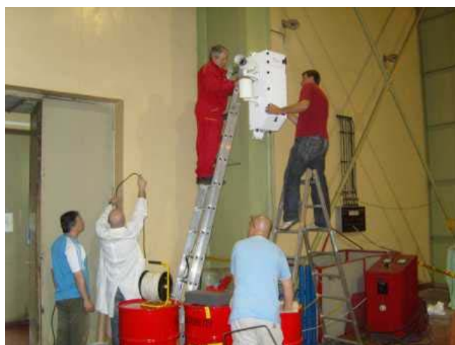
图 2. 正在安装用于加强核设施实物保护的远程监测设备。
