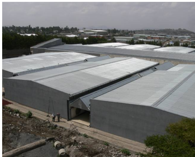
Construction du centre d'élevage et d'irradiation de la tsé-tsé à Kaliti, Addis-Abeba (Éthiopie).
