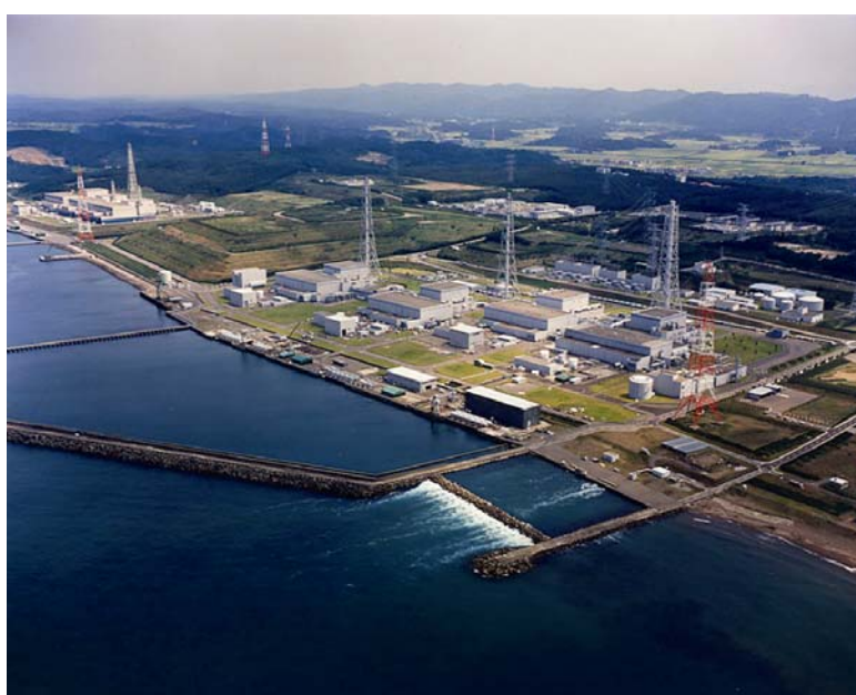
FIG. 1. La centrale nucléaire de Kashiwazaki-Kariwa.
