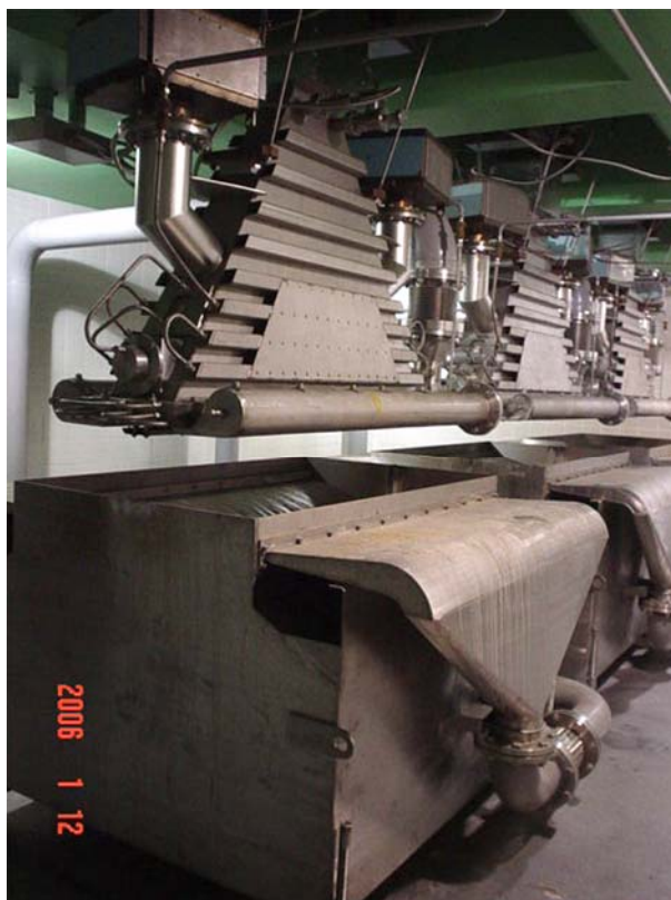
Рис. 1. Первая промышленная установка для электронно-лучевой очистки сточных вод, введенная в эксплуатацию в Республике Корея.
