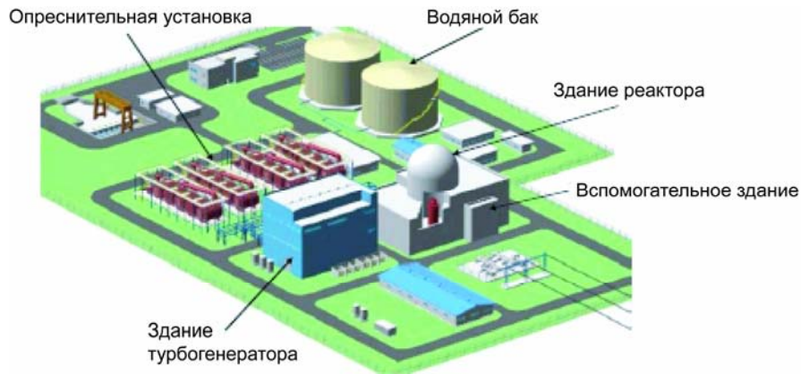
Рис. 2. Пример РМСМ — системно-интегрированный модульный усовершенствованный реактор (SMART) в Республике Корея (фото любезно предоставлено KAERI).
