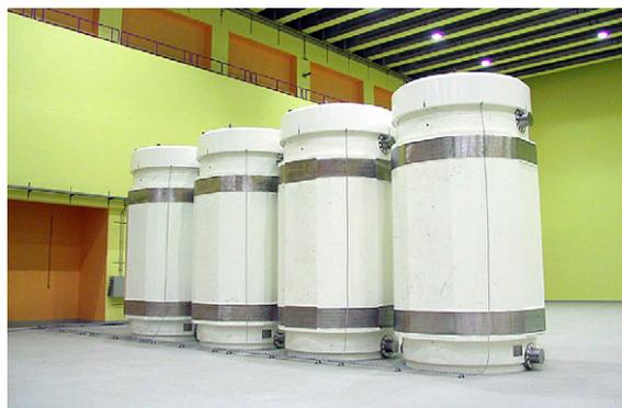
РИС. 2. Контейнеры для промежуточного хранения и транспортировки в хранилище ZWILAG, Швейцария.
