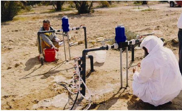
FIG. 1. En base a los resultados de un proyecto de cooperación técnica del Organismo, los sistemas de riego por goteo están comenzando a sustituir a las prácticas de riego en la superficie en las zonas áridas. La foto muestra un sistema de riego por goteo en la República Árabe Siria.
