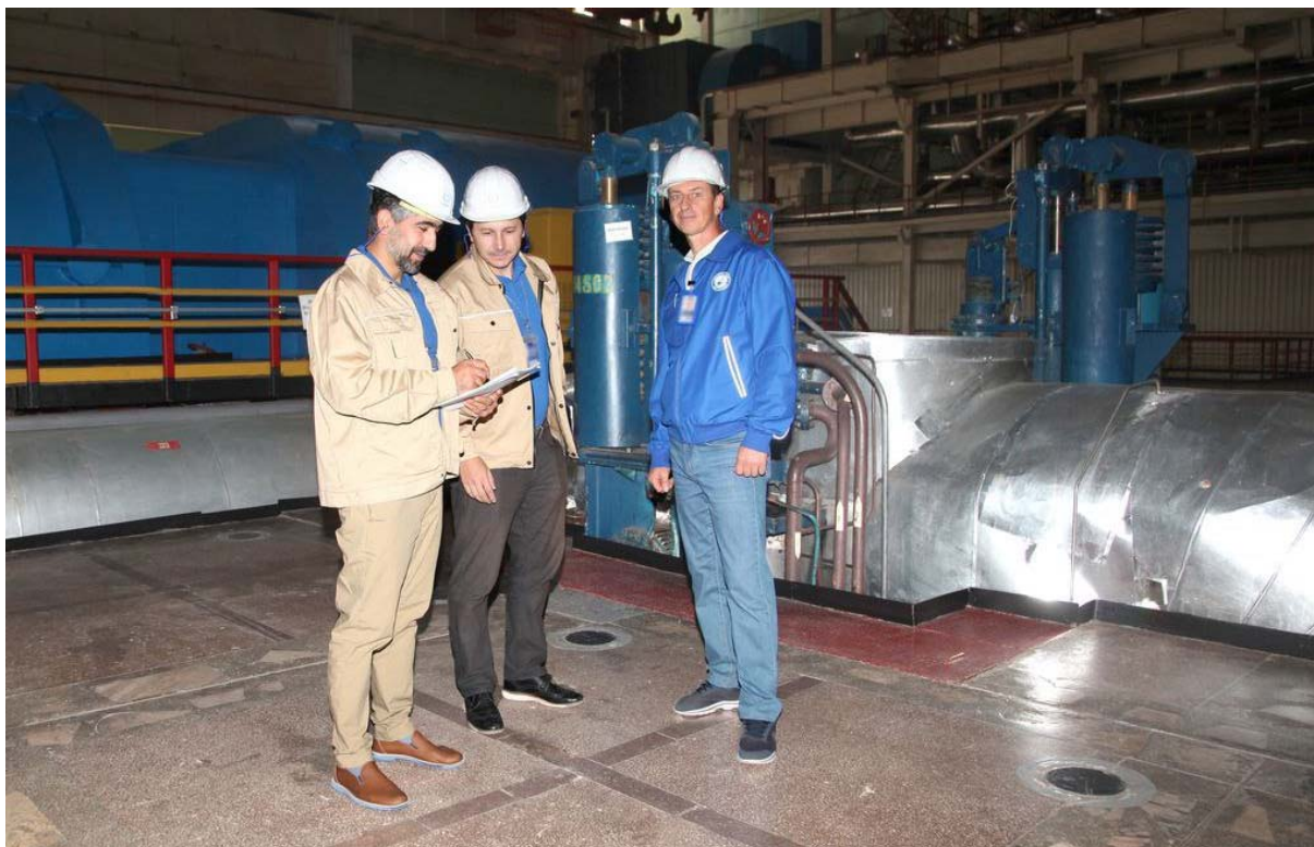
La ISAMISU lleva a cabo una visita de inspección en una sala de turbinas con sus homólogos en la SUNPP. (Fotografía: SUNPP).
