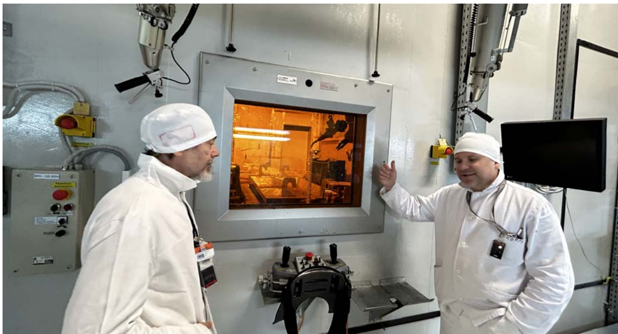
La ISAMICH visita la celda caliente en la planta de procesamiento de desechos sólidos en el emplazamiento de la ChNPP el 10 de abril de 2024. (Fotografía: ChNPP)
