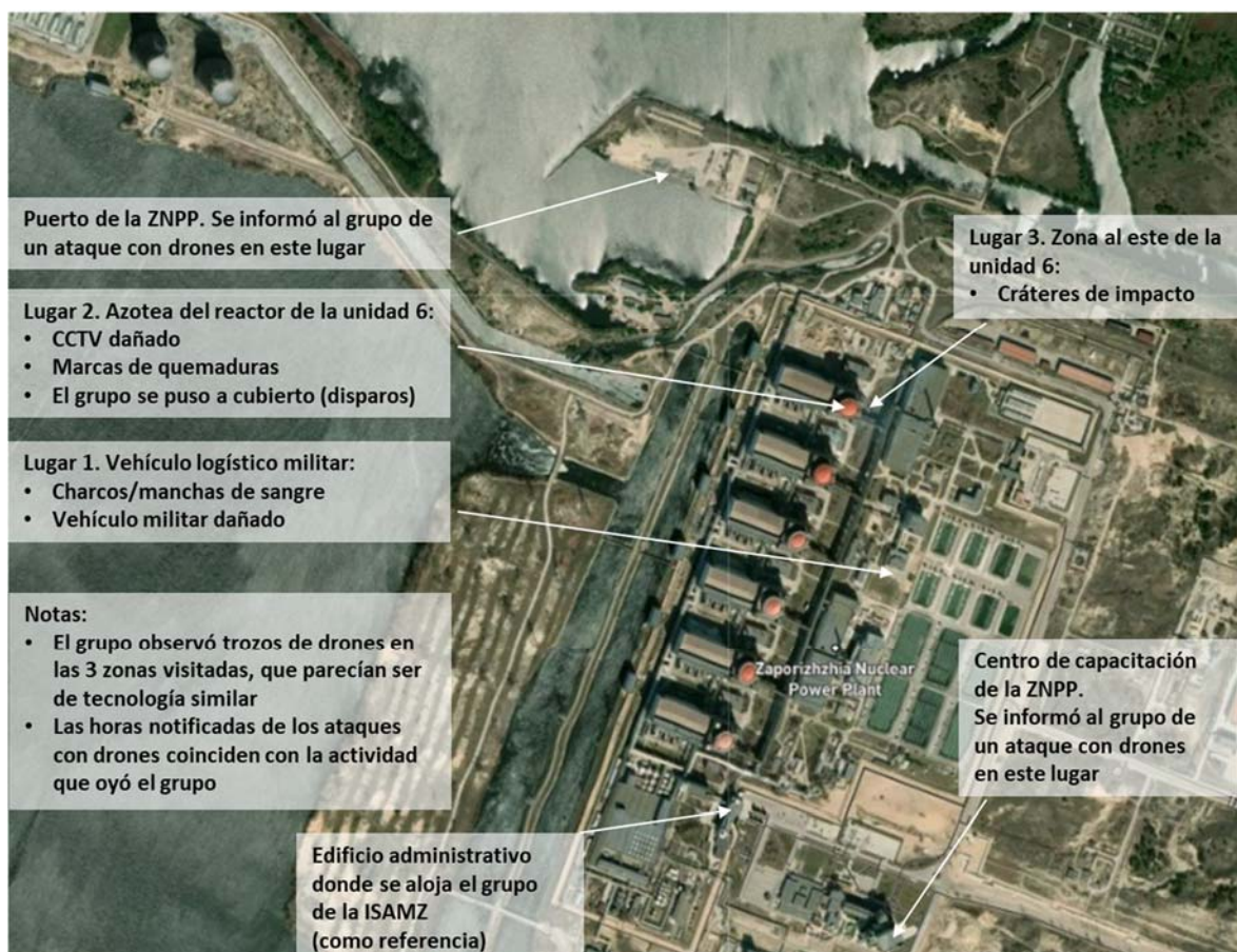
Ubicación de los tres lugares dentro del perímetro de la ZNPP visitados por la ISAMZ tras los ataques con drones notificados.
