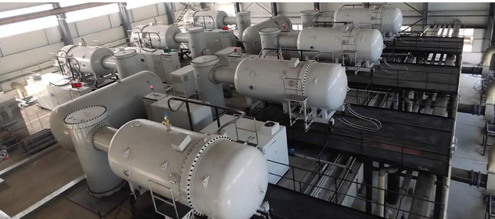
冠华针织厂7台电子加速器处理印染废水。（图/清华大学核能与新能源技术研究院）
