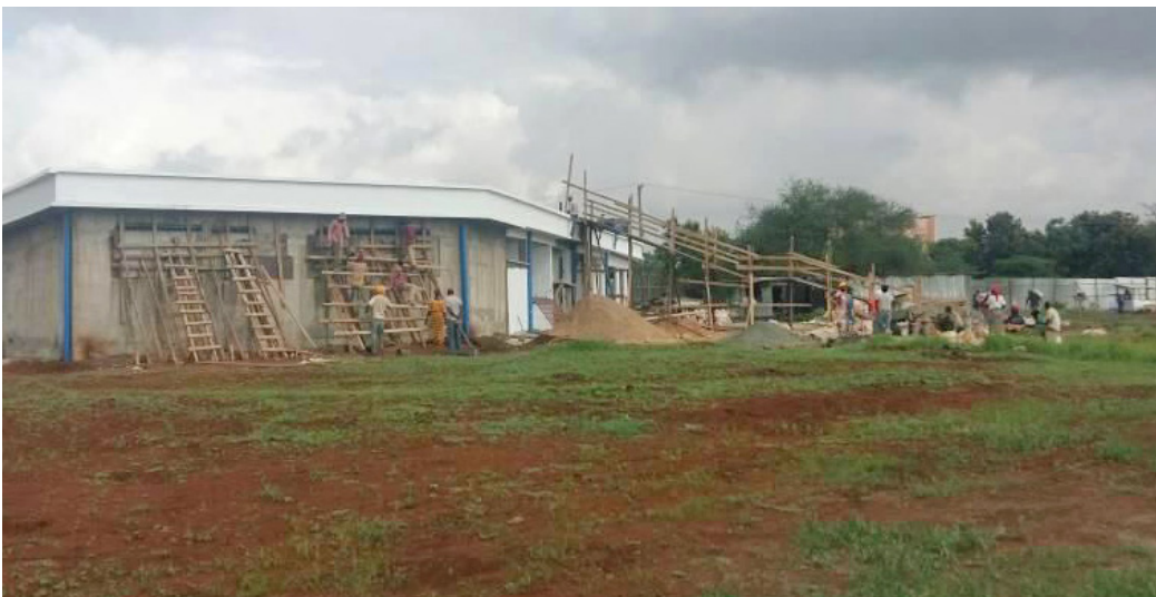
Première phase de construction du laboratoire d'analyse de l'uranium de la Commission tanzanienne de l'énergie atomique
