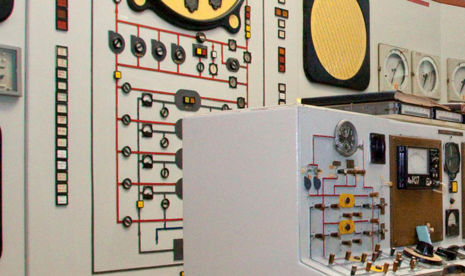
**Название АМ-1 происходит от слов «Атом Мирный». Реактор, управление которым осуществлялось из блочного пункта управления, имел полезную мощность 5 МВт. На этой фотографии оператор следит за состоянием 18 стержневых твэлов.**
