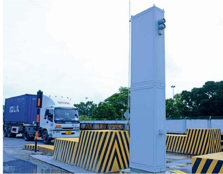
**6** Un monitor de radiación de pórtico detecta la radiación en tiempo real y no interrumpe las operaciones normales de exportación que se realizan en la frontera. Además, simultáneamente se identifican los contenedores mediante cámaras que capturan imágenes del camión e información detallada como, por ejemplo, la matrícula y el número de contenedor. La medición y las imágenes se transmiten a la Estación Central de Alarma (ECA) para su examen.
