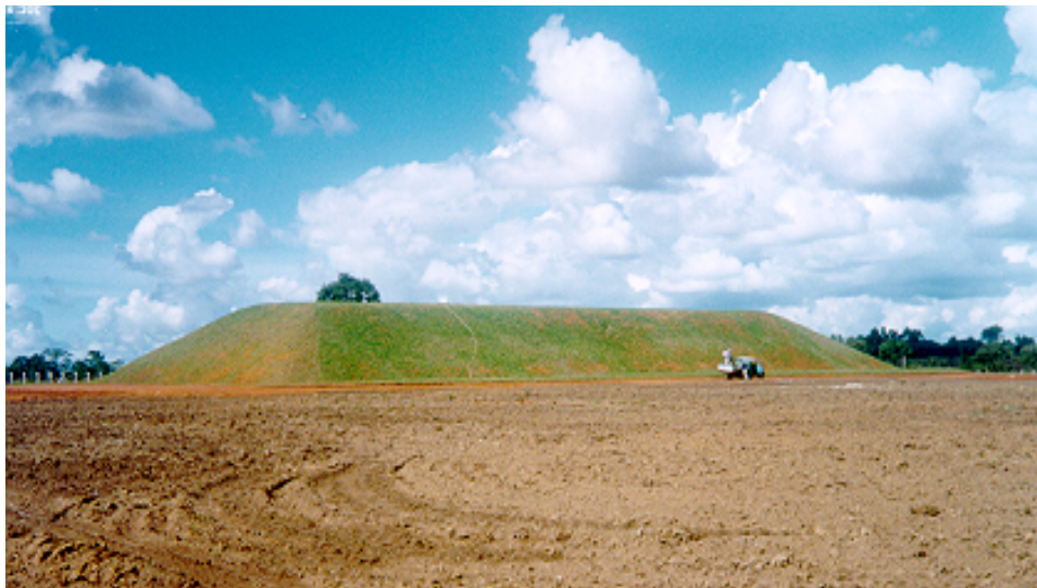
Fig. D.4. Repository at Abadia de Goiás
