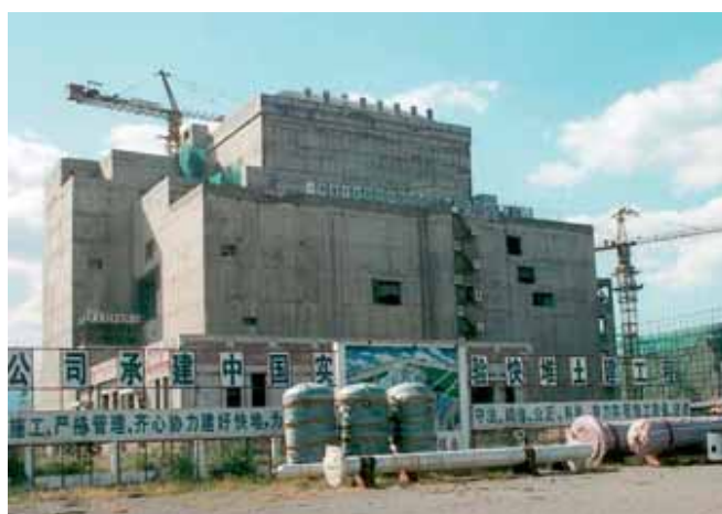
FIG. 2. El reactor rápido experimental chino en construcción.
