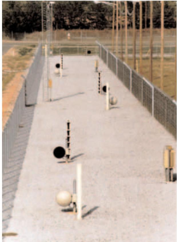
*FIG. 1. Exemple de système extérieur de protection physique servant à repérer des intrus tentant de s'introduire dans une installation nucléaire.*
