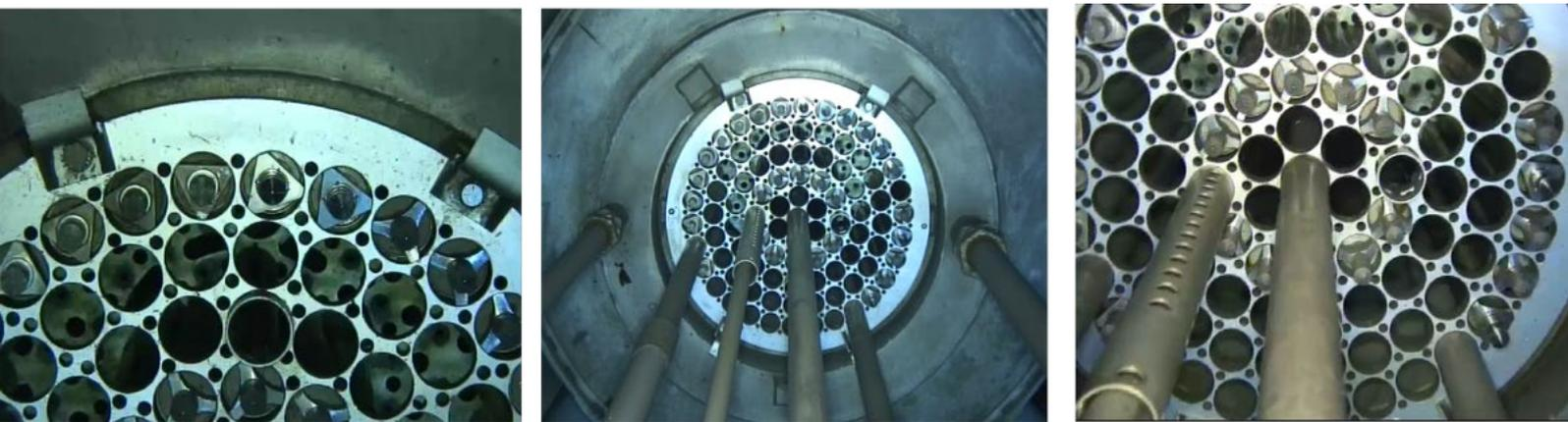
La exploración visual y los ensayos no destructivos se utilizan para evaluar la seguridad y las condiciones operacionales de las estructuras, los sistemas y los componentes de la instalación de un reactor, incluidos el soporte y la rejilla del núcleo.
