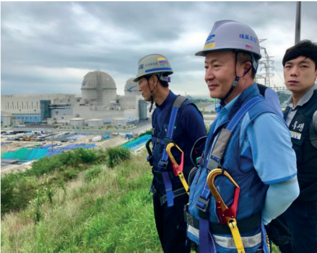
Personal directivo experimentado supervisa la construcción de la central nuclear de unidades múltiples de Shin-Kori.
