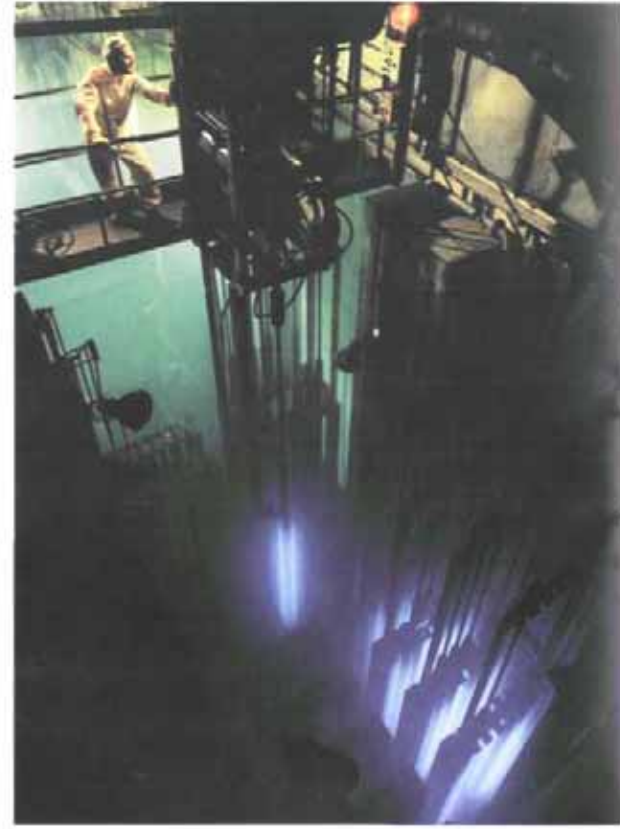
( الأعلى) قبل: بركة الوقود في مفاعل الماء الثقيل المولد للبخر في وينفريث، في حالة تشغيل المفاعل. (يساراً) بعد: الزوار ينظرون إلى بركة الوقود في وينفريث، الذي فُرع وأزيلت كلوثه بنجاح. (أخيراً) وكالة الطاقة الذرية البريطانية UKAEA
