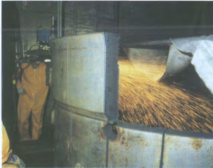
照片：在德国，在拆解一座原型堆期间，正在切割反应堆压力容器的封头。做好退役的规划能大大减少废物量。全世界最终需要退役的核电生产及相关设施有 800 多座。
