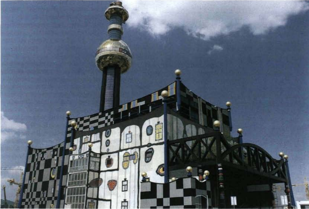
La planta municipal de incineración de desechos de Viena, cuya fachada fue diseñada por el pintor vienés Friedensreich Hundertwasser. (Cortesía: E. Schauer, Viena)
