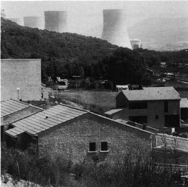
Central nuclear de Cruas en el sureste de Francia. (Cortesía: EDF)
