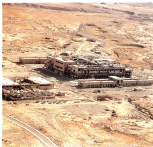
Escenas captadas durante las inspecciones del OIEA en el Iraq
