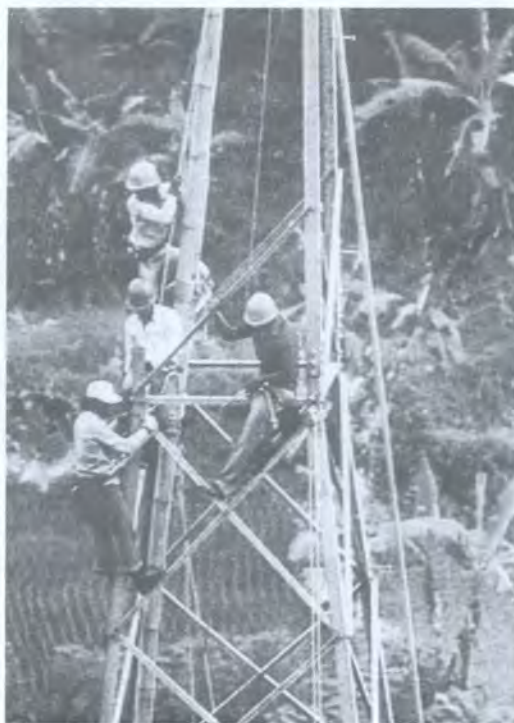
在东南亚等地区的发展中国家中,预计今后 20 年内发电装机容量将成倍增长。图为印度尼西亚工人在检查输电线路。(来源:EdF)
