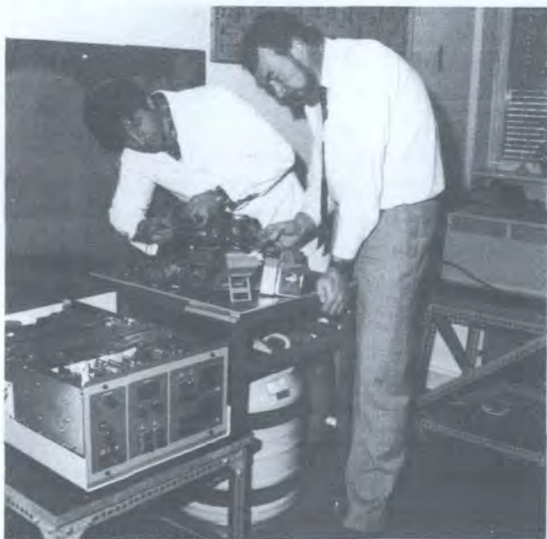
来自约旦的一位进修人员学到了XRF系统的维护和修理经验，该系统是IAEA的一个技术合作项目的一部分。
