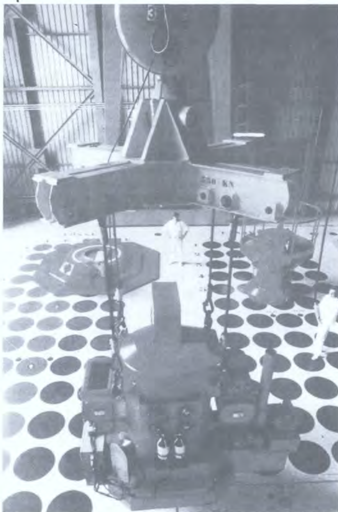
На установке в Маркуле, Франция, контейнеры с остеклованными высокоактивными отходами транспортируются в охлаждаемые воздухом колодцы для временного хранения. (Предоставлено: ANDRA)
