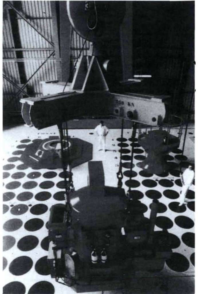
A l'atelier de vitrification de Marcoule (France), les conteneurs de verre de haute activité sont provisoirement stockés dans des puits ventilés. (Photo ANDRA)
