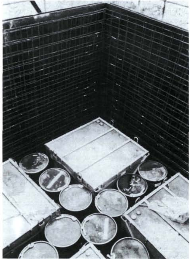
En Francia, el emplazamiento de evacuación de La Manche incorpora barreras técnicas complejas para impedir que los desechos radiactivos entren en contacto con las aguas subterráneas. (Foto: ANDRA.)
