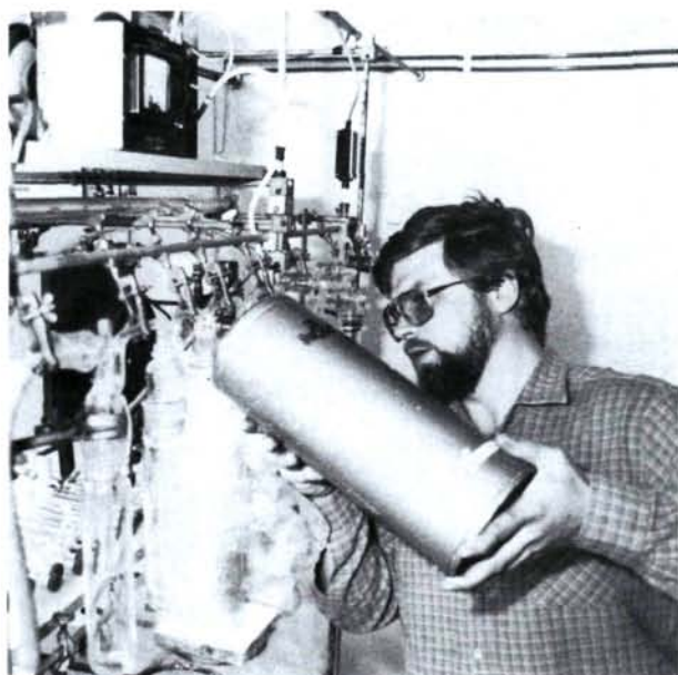
El sistema de preparación del gas de tritio figura entre los instrumentos analíticos del laboratorio de hidrología isotópica del OIEA en Viena. (Cortesía: Katholitzky para el OIEA)
