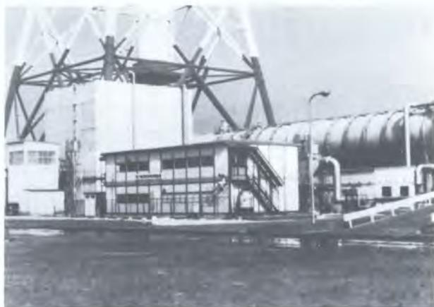
Данная опытная установка в Японии использует радиацию для обработки отработанных газов из сталеплавильной агломерационной печи Исследовательской ассоциации по уменьшению содержания и удалению  $\text{NO}_x$  в сталеплавильной промышленности
