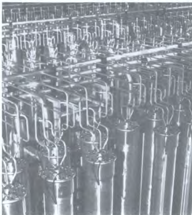
Каскадная центрифуга на заводе по обогащению урана в Японии. (Фото КАЭ Японии)
